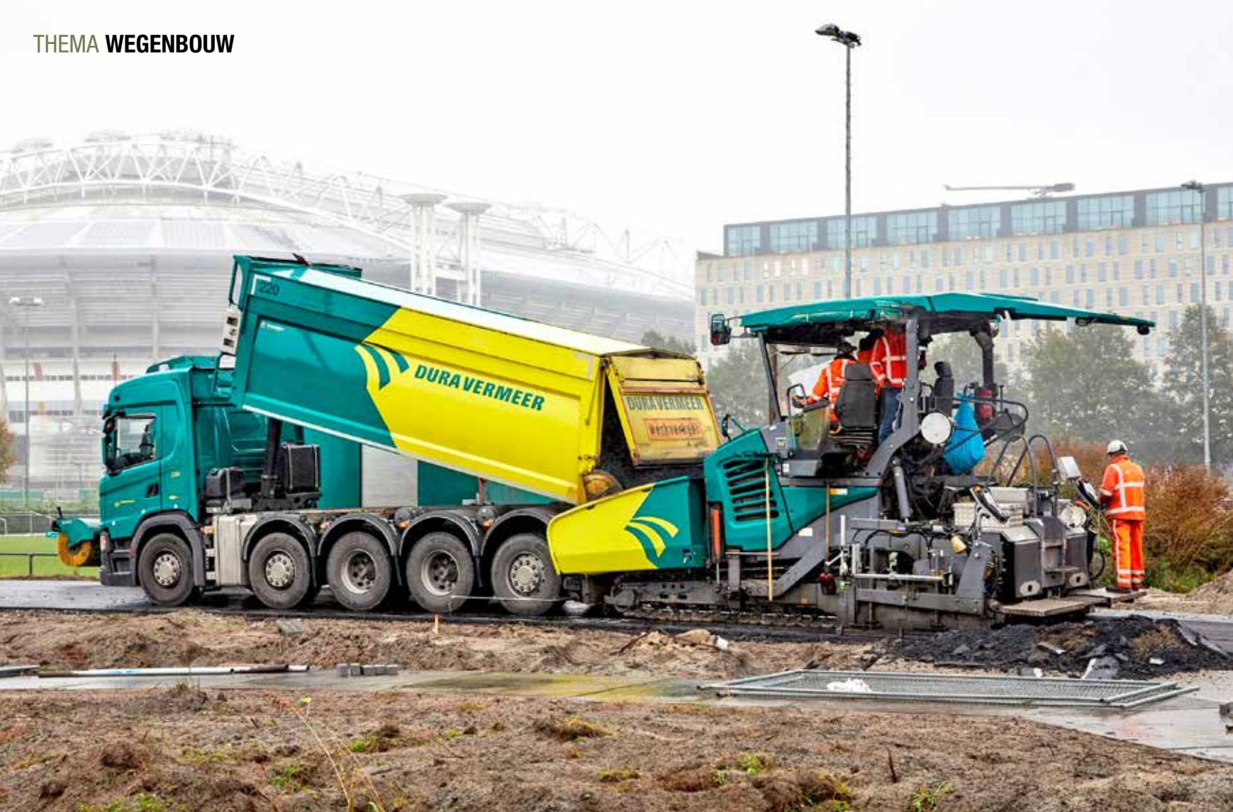
De 100% circulaire deklaag voor een nieuwe weg in Amsterdam is een wereldprimeur.
