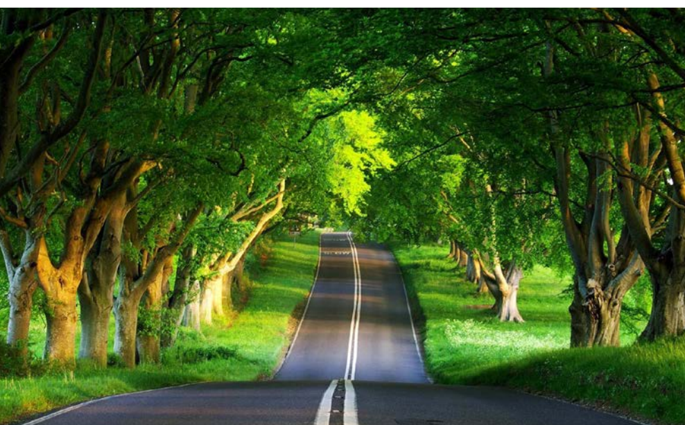
Waar zwart (asfalt met hergebruikt bitumen) en groen elkaar ontmoeten.
