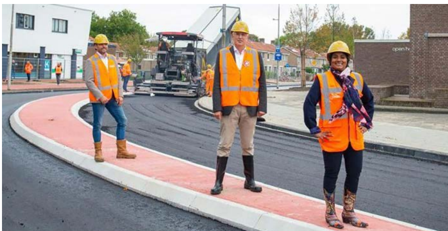
Wethouders Irene Korting (r) en Ton van Amerongen (midden) van gemeente Dronten en ing. Marco Kok (achteraan) van Roelofs Groep bij het nieuwe asfalt van De Zuid dat is gemaakt van het oude dak van zwembad Overboord.
