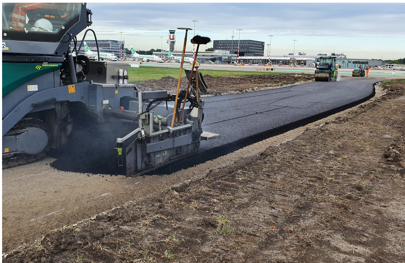
Asfalt met bitumen van Roof2Road op Zestienhoven Airport.
